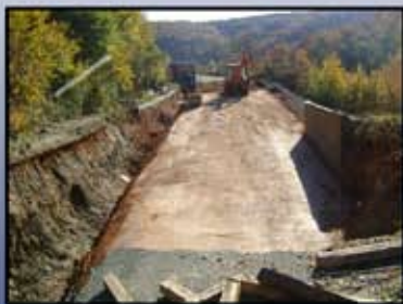
Уплътняване и заравняване на работната площадка
