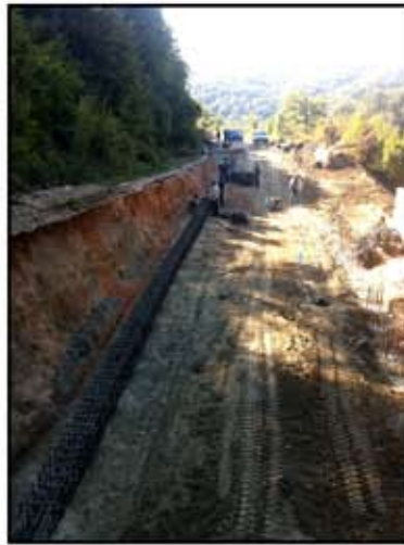
Полагане на армировка на обединителна греда по ос „Б“ и свързването и с пилотите
