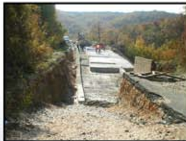
Завършен първи етап Подготвяне на площадката за полагането на армонасип
