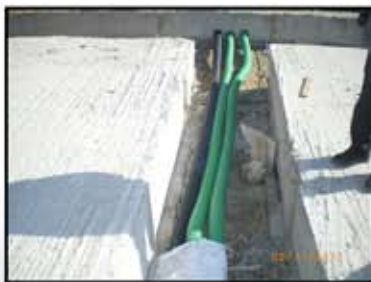
Дренажно ребро и отводнителни канали
