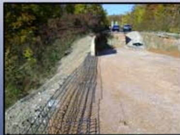
Подготовка за изграждане на армонасипен откос
