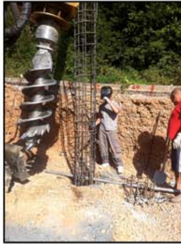
Поставяне на армировка на пилот №70 по ос „Б“
