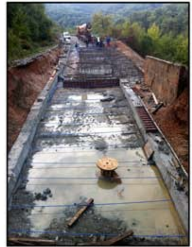
Изградени обединителни греди по оси „А“ и „Б“ с анкерни въжета между тях. В дъното се вижда полагане на армировка за конзолна конструкция и подготовка за изграждане на дренажни ребра през укрепителната система
