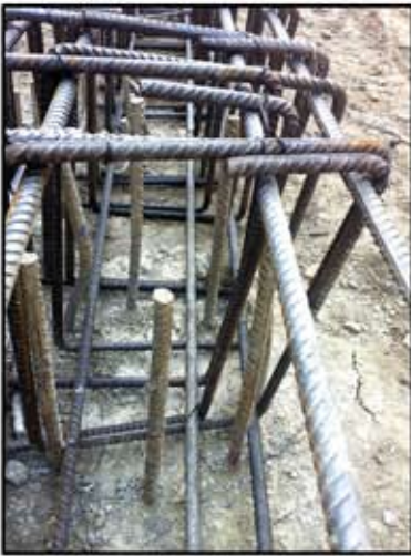
Армировка на обединителна греда по ос „Б“ в момент преди свързването и с пилотите
