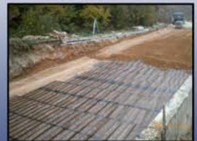
Застилане на земен пласт върху вече положен армонасипен слой
