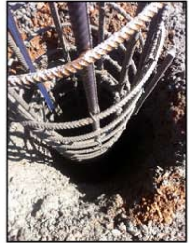
Поставена армировка и подготвителни дейности преди изливането на бетона
