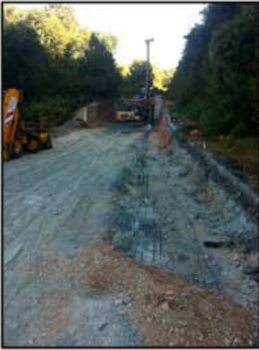
Пилот-машина (в дъното) и вече изградени пилоти по ос „Б“
